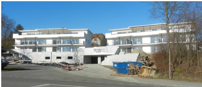
Neubauten Mehrfamilien- häuser an der Luzernstras- se
